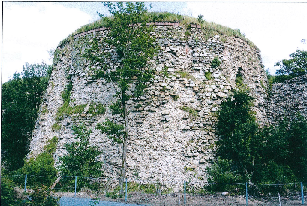
Ściana wieży – strona północno-zachodnia
