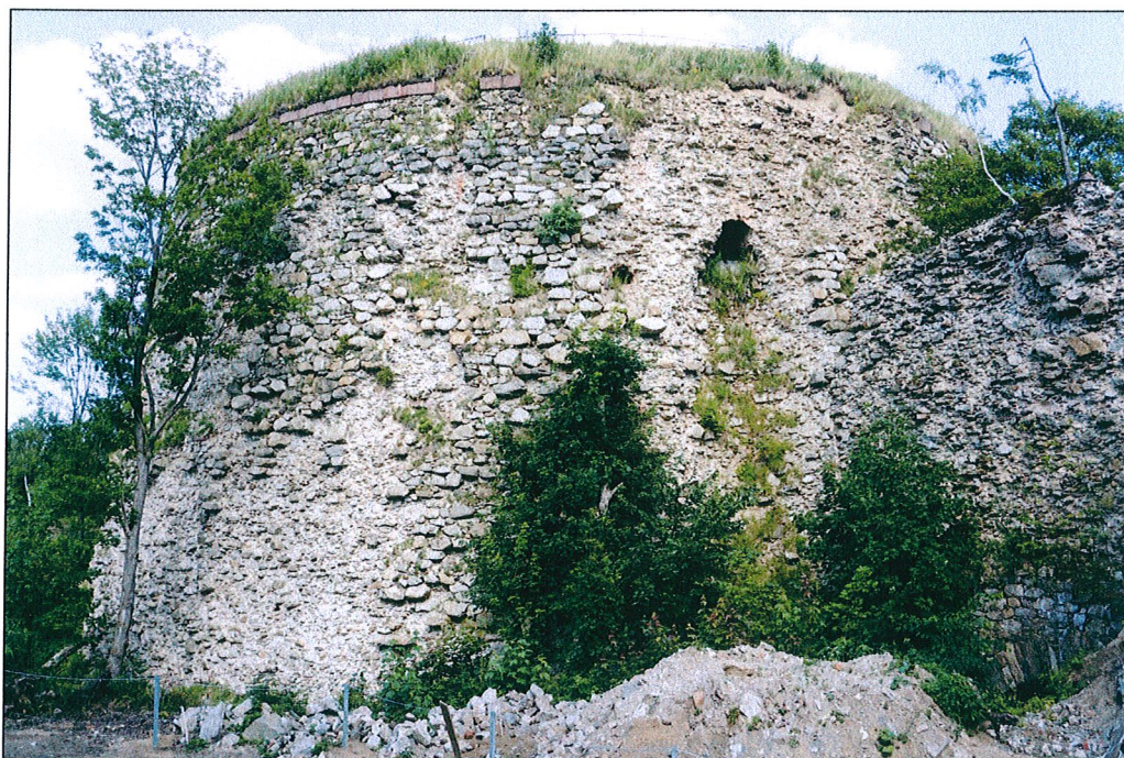
Ściana wieży – strona zachodnia
