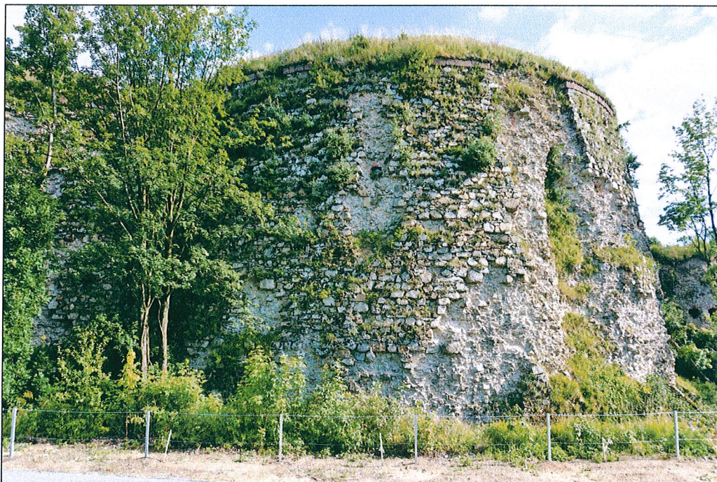
Północno wschodnia część wieży
