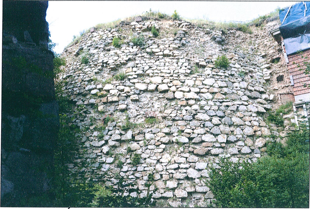
Ściana wieży – strona południowo-zachodnia
