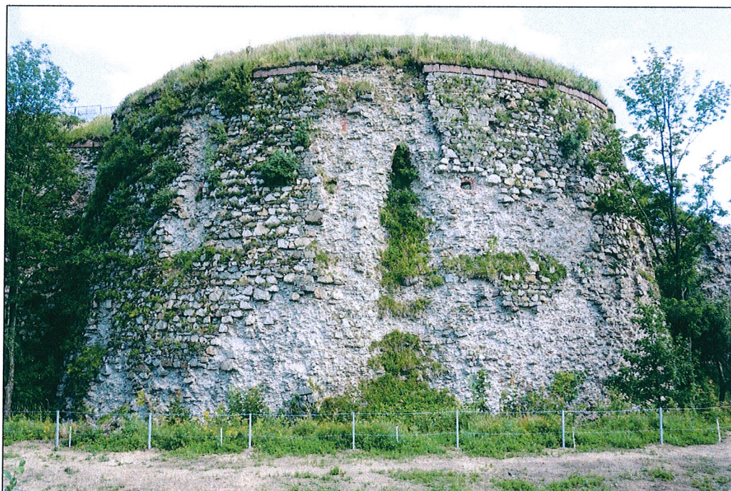
Północna część wieży
